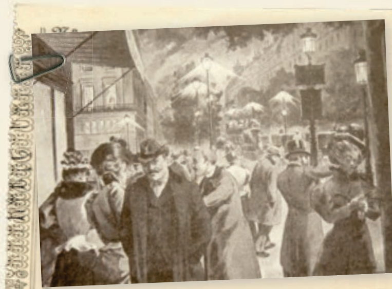
Eclairage électrique des Grands Boulevards NB : On remarque les candélabres mixtes gaz et arc électrique
